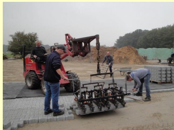
Ook straatwerkzaamheden zijn voor de mannen van de Groengroep geen enkel probleem
